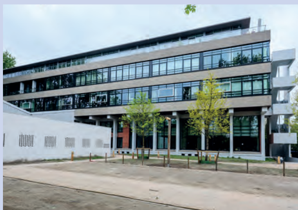
Klaslokalen hebben plaatsgemaakt voor 75 appartementen in een voormalig HTS-gebouw in Groningen.
