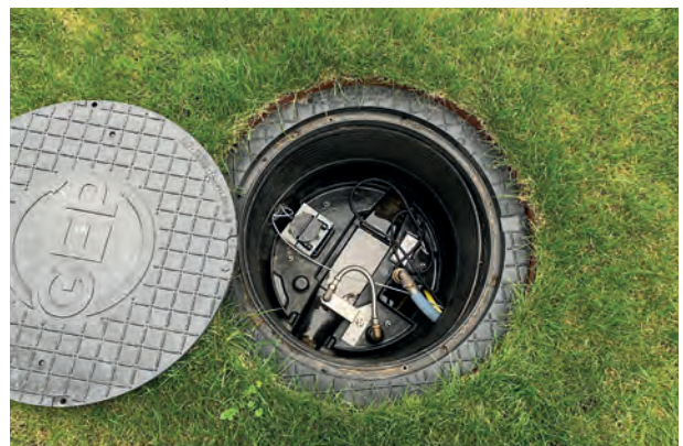
Het enige wat na aanleg van een buffervat voor regenwater zichtbaar is, is een zogenaamd mangat.
