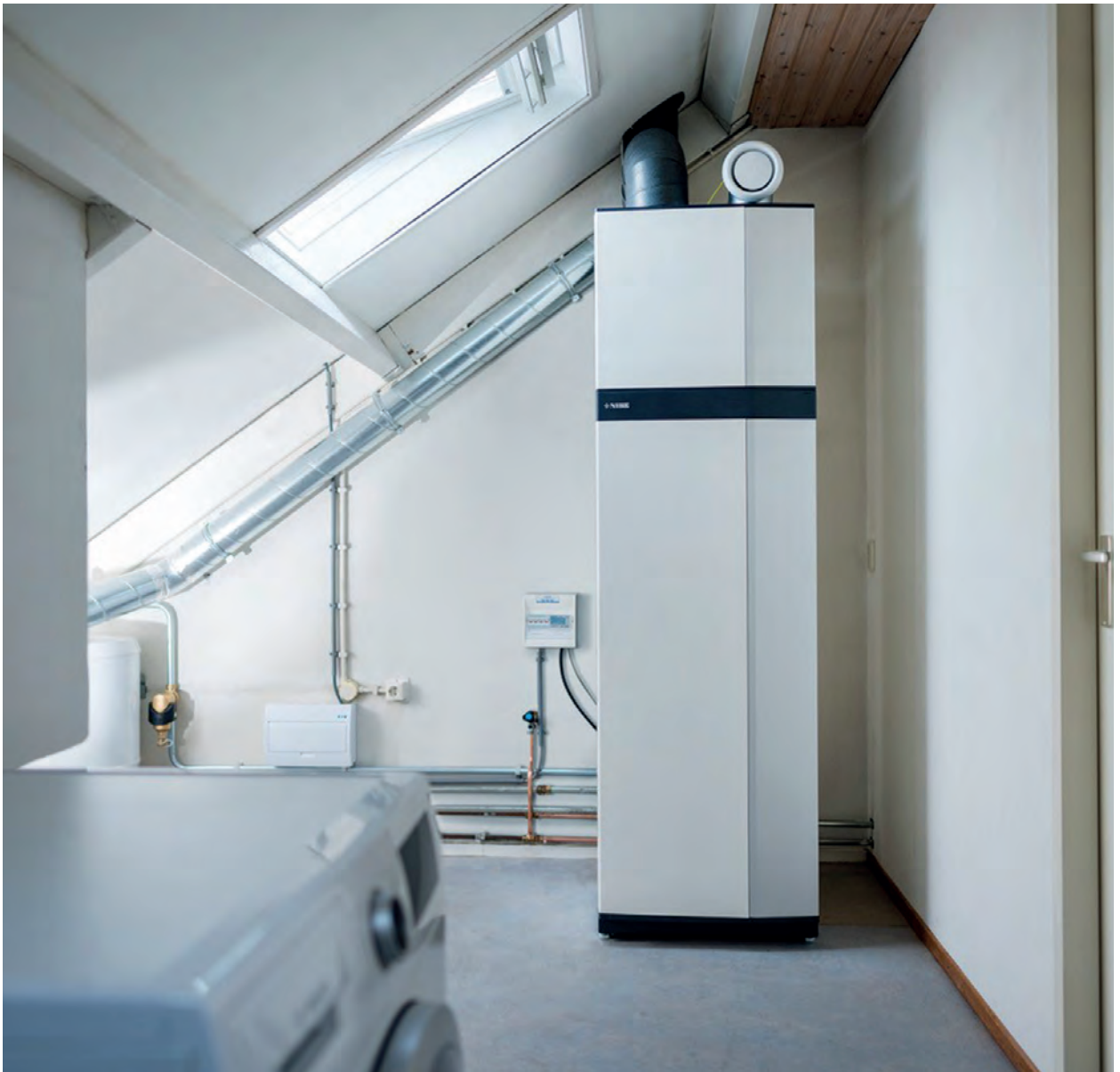
Nibe maakt in zijn nieuwste ventilatielucht/water-warmtepomp gebruik van het koudemiddel propaan.
