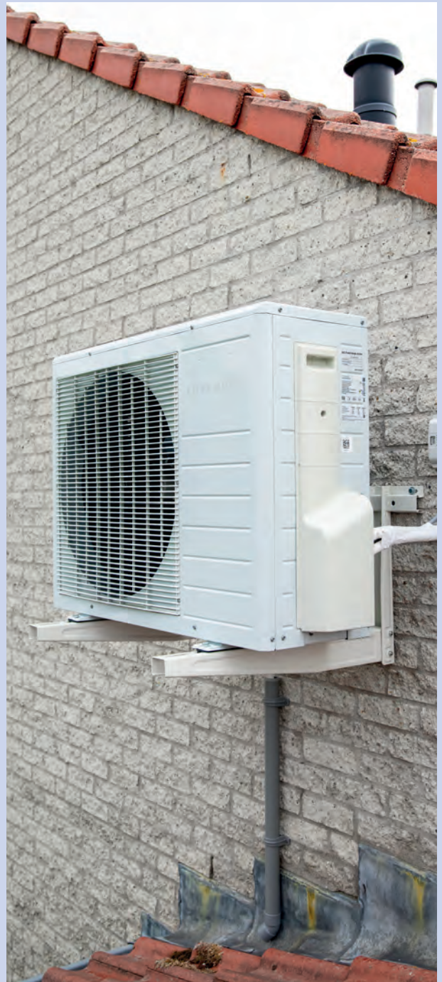
Het buitendeel is standaard voorzien van een hoogwaardige coating en is bestand tegen het heersende zilte klimaat.
